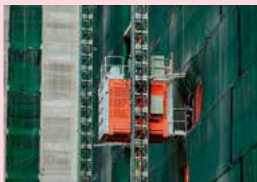
工事用エレベータ・リフト
